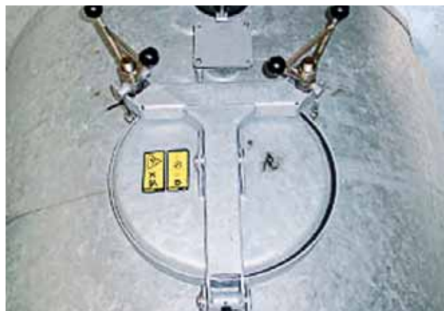
Horný otvor Ø600 mm s odklopným vekom.
